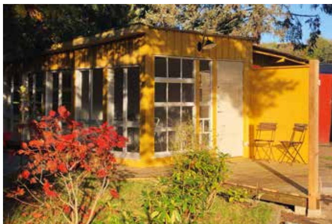
Det nybyggda orangeriet.
